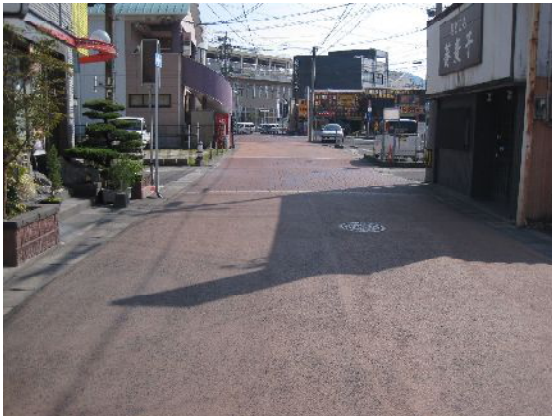
透水性アスファルトの施工状況
