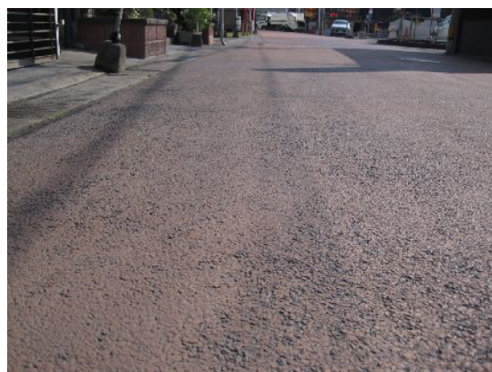
透水性アスファルトの施工状況
