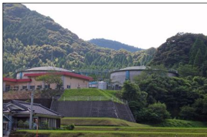
耐震化が必要な台明寺配水池(国分地区)
