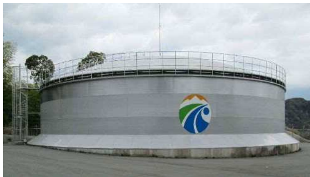
木之房配水池
