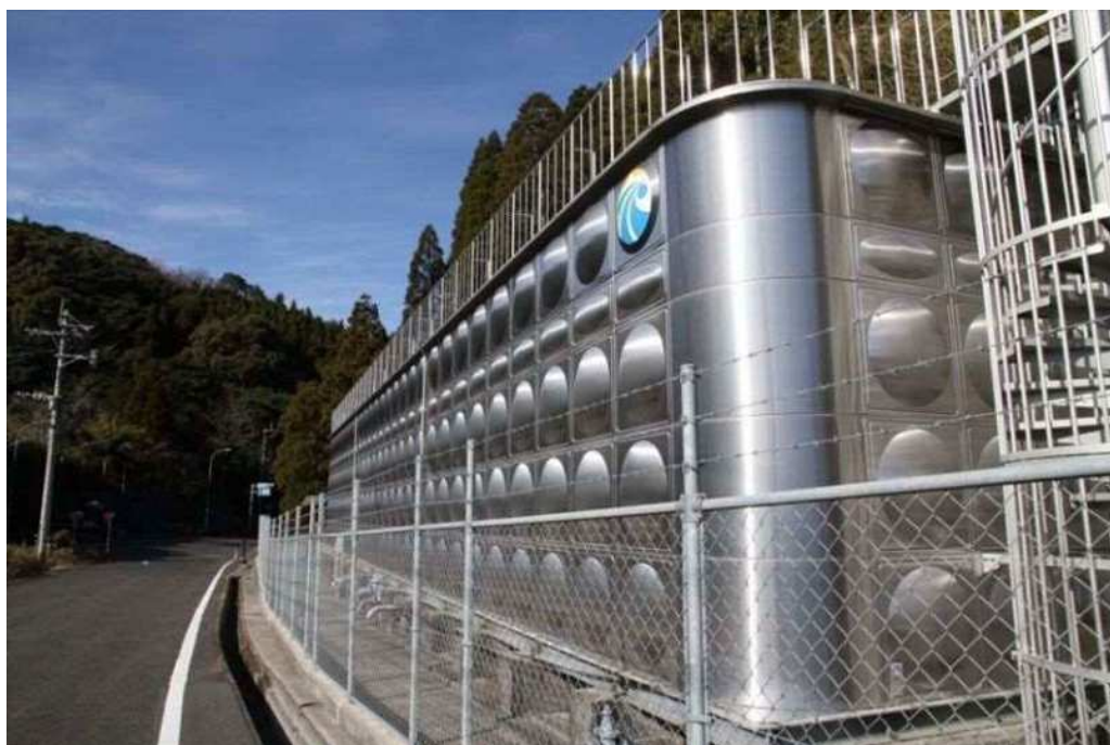
フェンス設置状況
