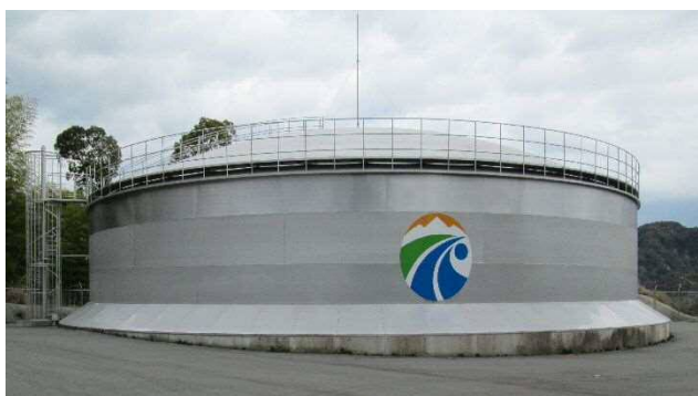
木之房配水池
