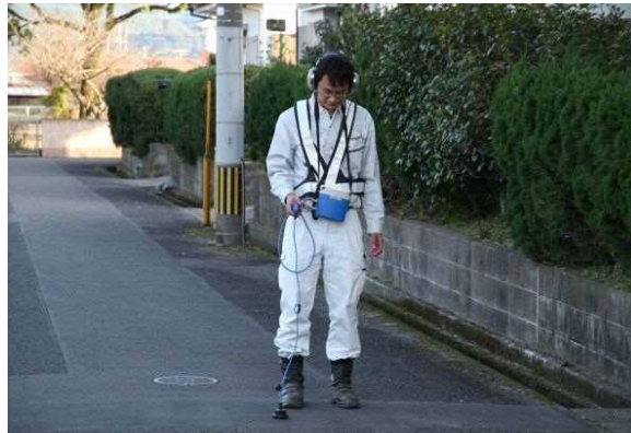
漏水調査状況
