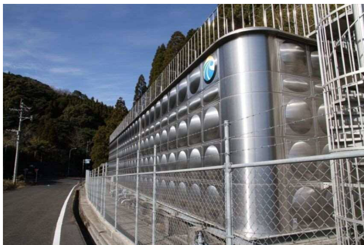
フェンス設置状況
