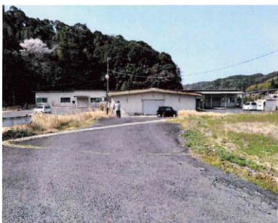
3 北から見た全景
