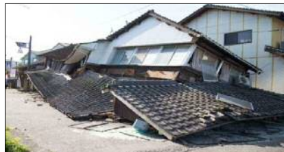
(熊本地震の被害状況)
