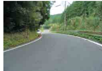
市道整備事業(国分5路線、溝辺2路線、横川3路線、牧園2路線、霧島2路線、隼人7路線、福山1路線) 事業内容/整備延長3,500m 事業費/3億9,510万円 実施地区/全域
