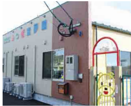
保育所緊急整備事業 事業内容/みつぎ重夢園の増改築整備を行い定員増を図った(定員30人⇒50人) 事業費/3,780万円 実施地区/隼人
