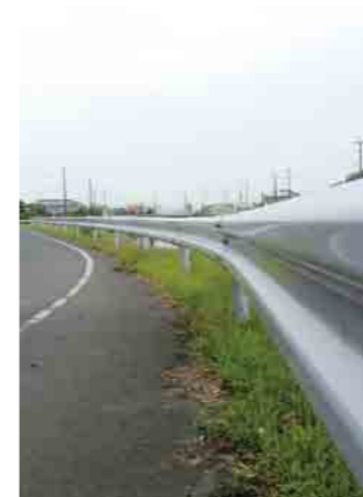
交通安全施設整備事業 事業内容/整備施設数135か所 事業費/2,211万円 実施地区/全域
