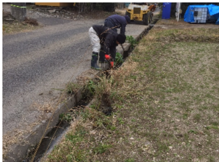
農地維持 水路の泥上げ
