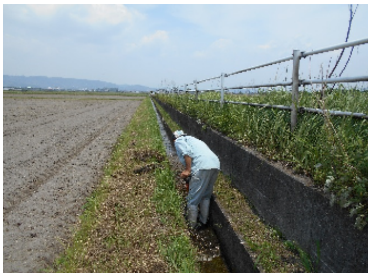
農地維持 水路の泥上げ
