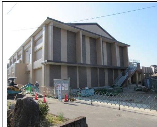
▲【新工場】 足場が撤去されて新工場の外観がお披露目となりました。
