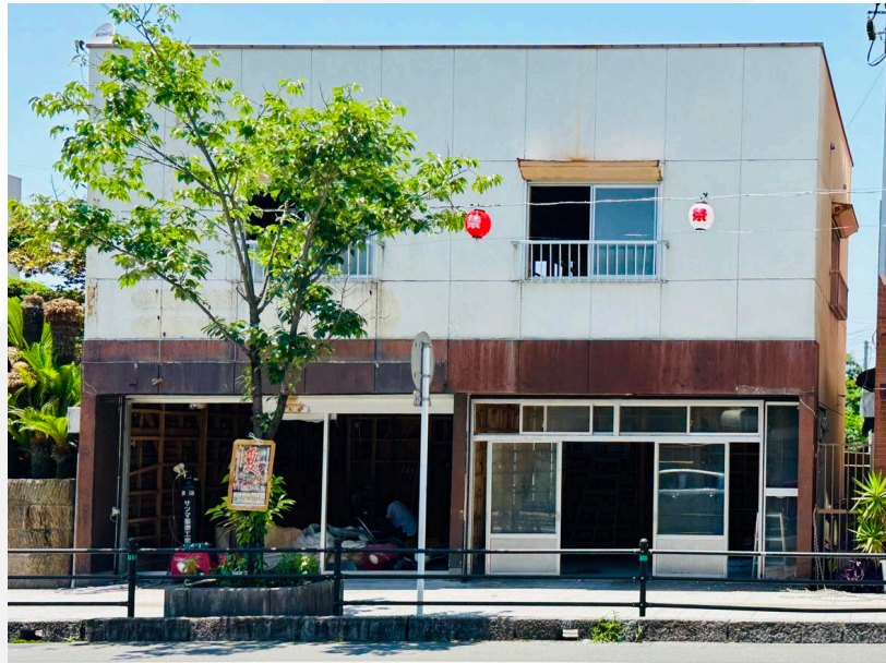
空き店舗改修 (2023.7月~)
