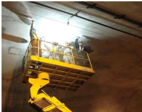
近接目視によるトンネル点検
