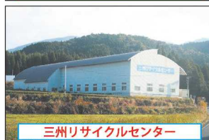
三州リサイクルセンター
