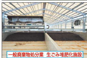
一般廃棄物処分業 生ごみ堆肥化施設
