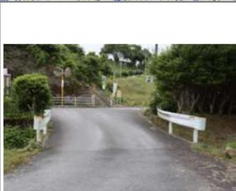
1.紫尾田活性化センター入口付近、ガードレールの間隔が大きく側溝に落ちる危険性がある。
