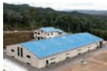
写真②：加治木町にあるクローズド式処分場
