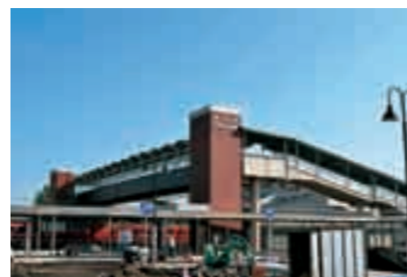
6月1日に向けて工事が進む西口駅前広場
