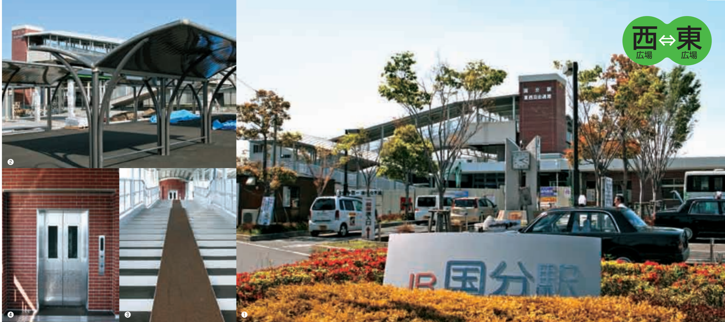
①東口駅前広場と建設中の自由連絡通路 ②駐輪場 ③自転車用スロープ ④エレベーター
