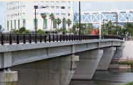
国分地区と単人地区を結ぶ「天降川橋」全長155m、幅16mの片側1車線。周辺道路の渋滞緩和を目的として平成10年度から整備を進め今年4月に完成した。
