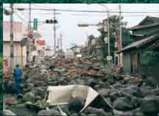
土石流により島原市の道路は寸断
