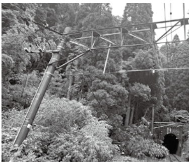
倒木が原因で傾いた電柱
