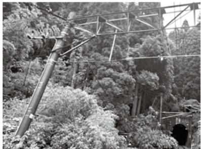
倒木が原因で傾いた電柱
