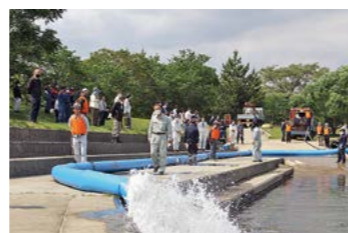
送排水ポンプ導入管理事業 事業内容/内水氾濫箇所における緊急時の排水対策として、移動式送排水ポンプ(15,000ℓ/分)を2組購入 事業費/8,789万円 実施地区/全域
