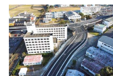
街路整備事業 事業内容/山崎線道路改良舗装工事(橋りょう25.5mを含む、延長157m、幅員12m) 事業費/27,934万円 実施地区/国分
