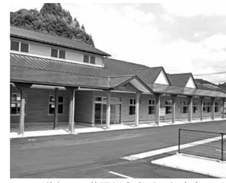
5月に移転した牧園総合支所の新庁舎
