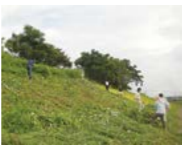
堤防の草刈り作業の様子
