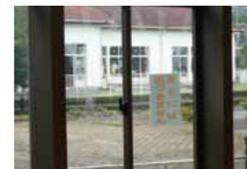
飛散防止フィルムを貼った窓ガラス
