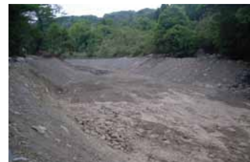
除石工事を行った霧島川6号堰堤(霧島神宮付近)
