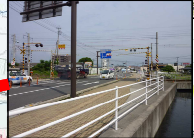
交通量の多い踏切 歩行者・自転車も多く危険
