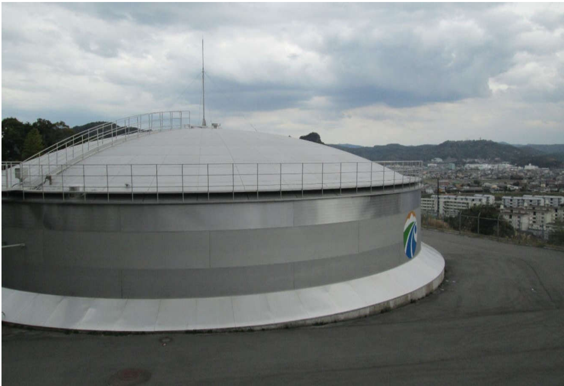
隼人木之房配水池
