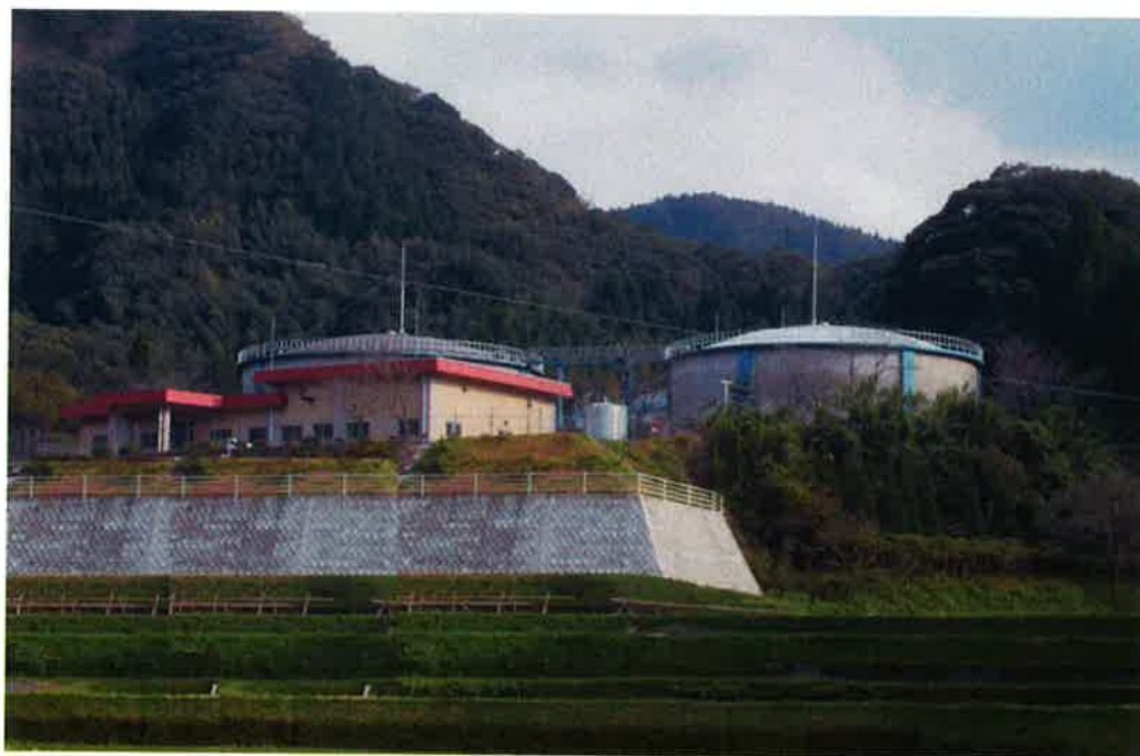
国分台明寺配水池
