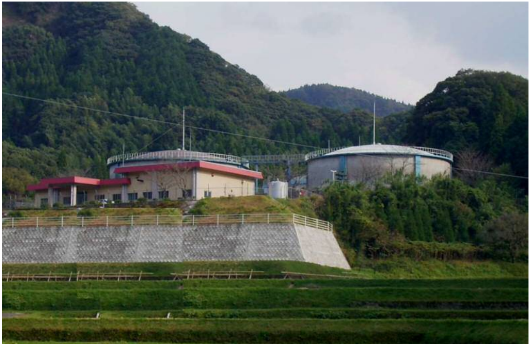
国分台明寺配水池
