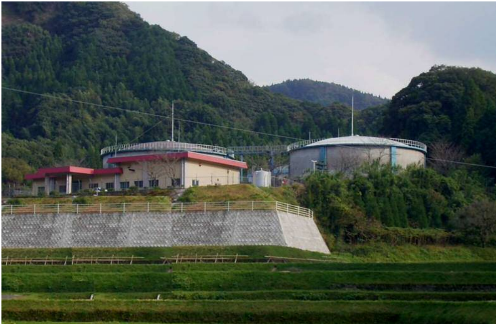
国分台明寺配水池
