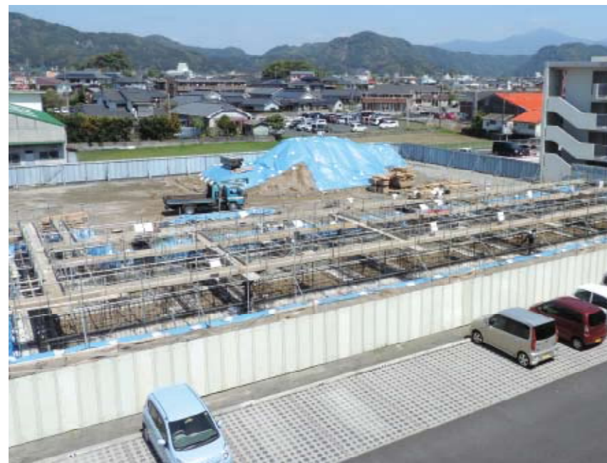
建て替え建設工事の木之房団地
