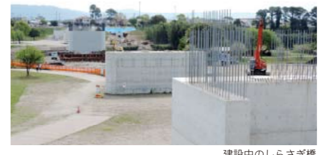
建設中のしらすぎ橋
