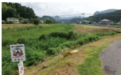
郡田川青葉橋付近
