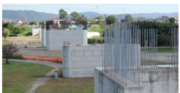
建設中のしらさぎ橋
