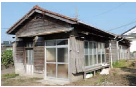
解体予定の松木住宅
