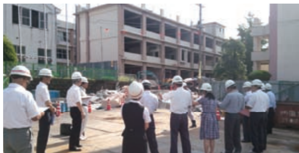
国分中央高校3号棟の工事現場
