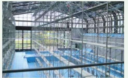
改修中の国分総合プール
