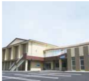
完成した関平鉱泉所
