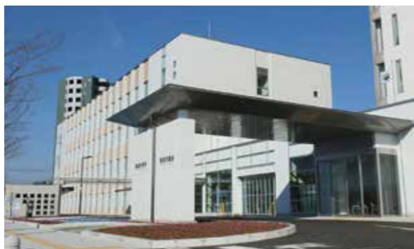
完成した国分庁舎別館
