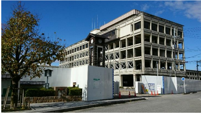
耐震化工事中の彦根市役所
