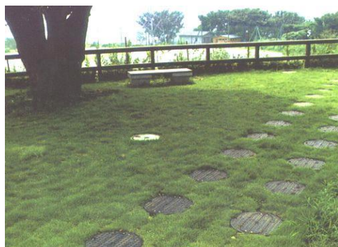
災害時は非常用トイレになる
