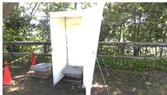
災害発生時にはベンチがトイレになる
