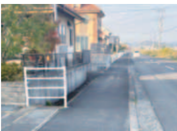
転落防止柵のない歩道
