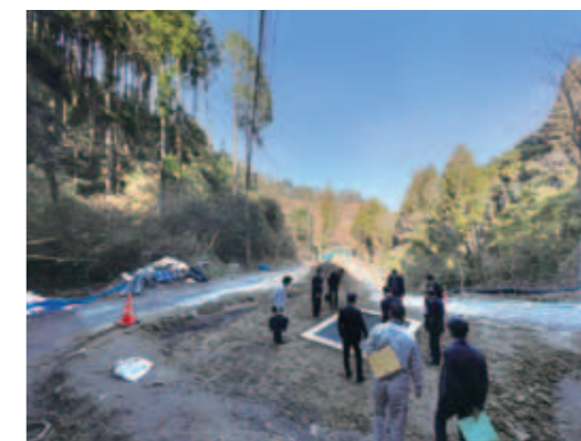
市道上之段～塚脇線 工事現場視察
