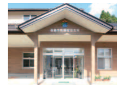
牧園総合支所新庁舎等整備事業
