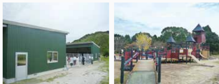
国分球場ブルーペン新築工事 丸岡公園遊具交換改修工事
