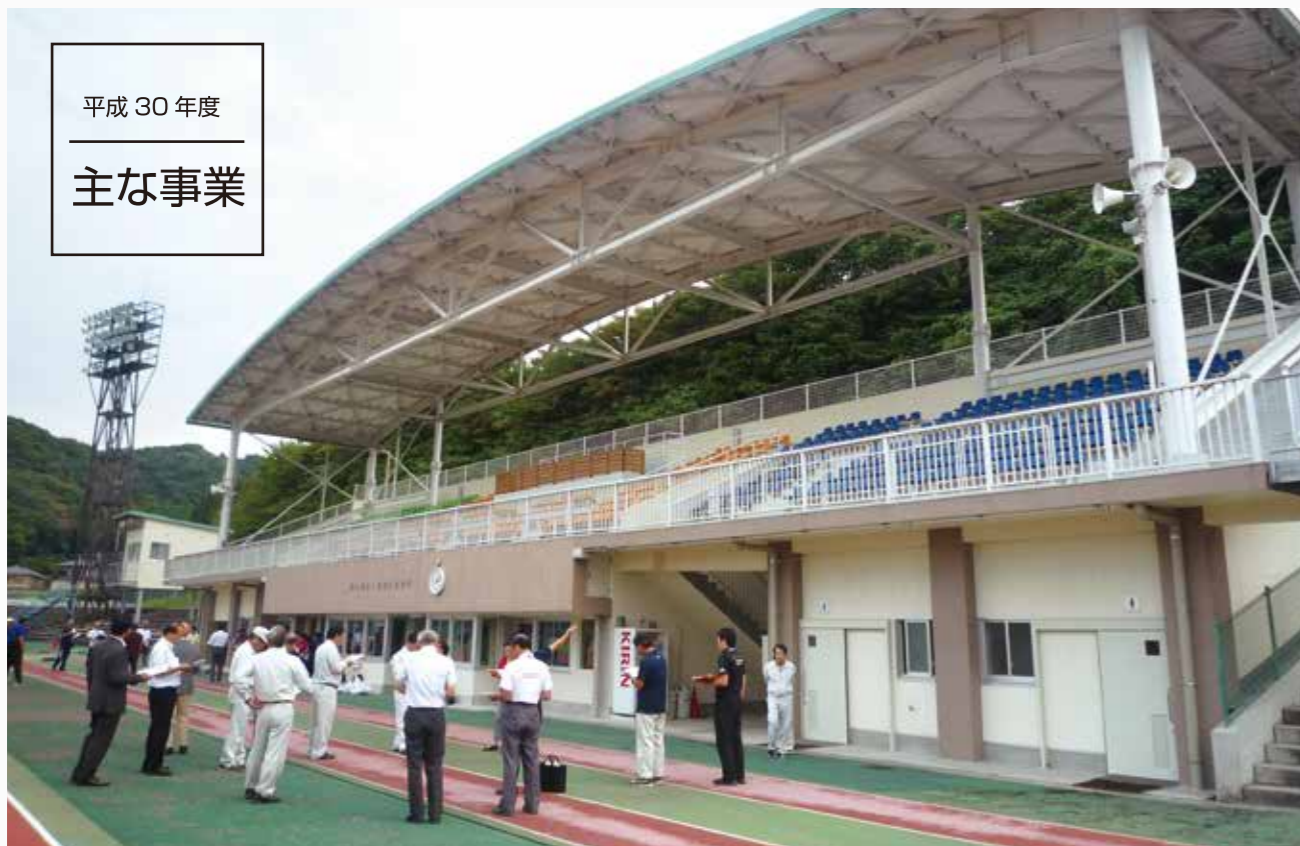
国分陸上競技場メインスタンド改修工事
