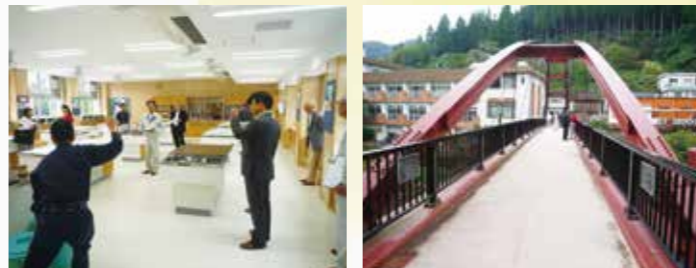
日当山中学校 校舎大規模改造建築工事 虹のつり橋橋梁補修工事
