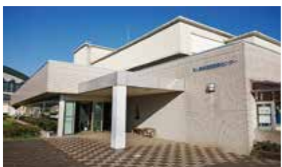
福祉避難所に指定されている隼人農村環境改善センター
