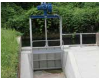
整備された牟田放水門
