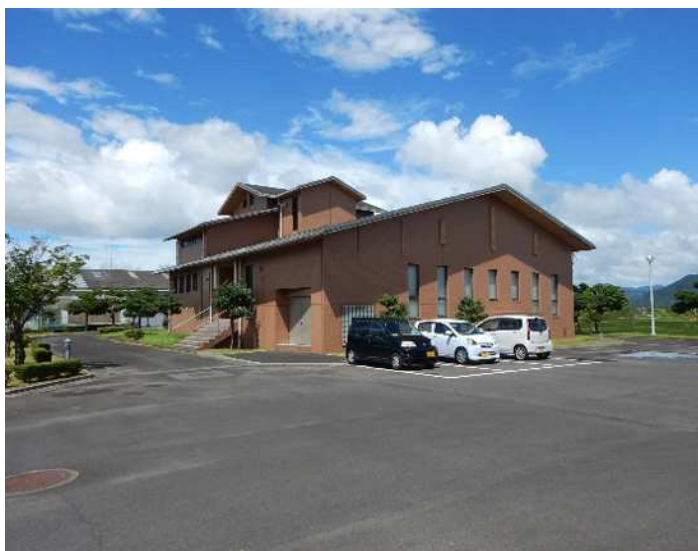
<国分隼人クリーンセンター ポンプ場>
